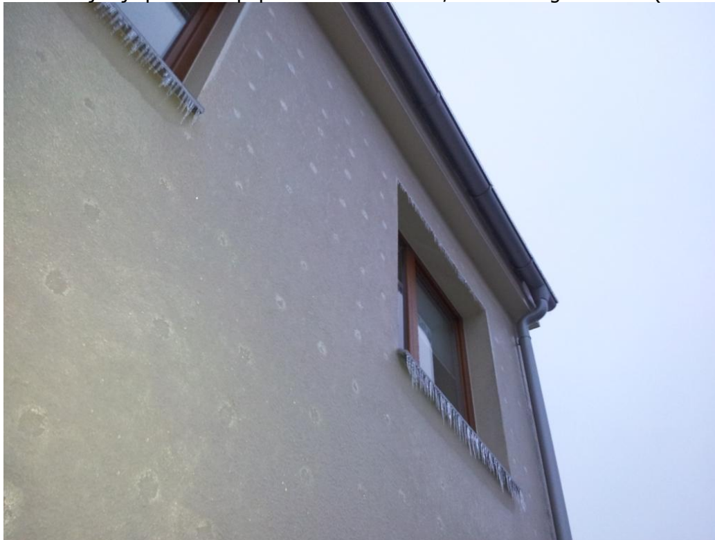
Fotografie s výsledky chování bodových tepelných mostů na povrchu ETICS, které vyvolává teplotní rozdíl mezi dvěma teplotními poli za extrémního počasí (XII.2014).
